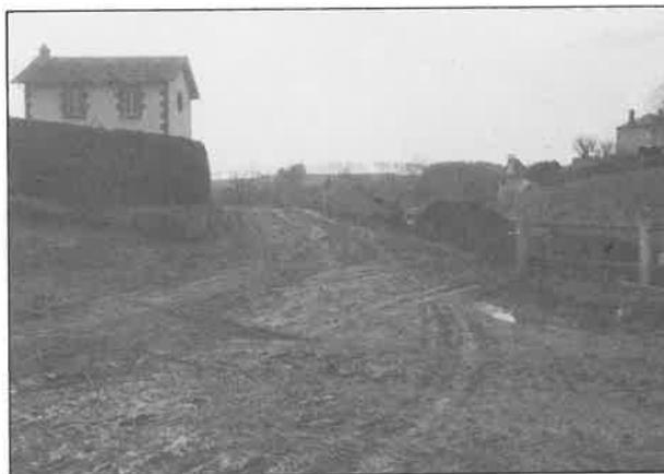
Du carrefour de Lagarde au pont, un élargissement à 5 m et un renforcement de la chaussée seront réalisés afin d'améliorer la visibilité et la sécurité dans ce secteur. Les travaux vont débiter prochainement après que les services d'EDF aient déposé les poteaux électriques gênants.
